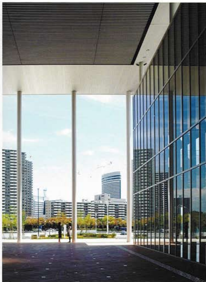
キャニオン 高さ13mの列柱は直径400mmのPRC柱
